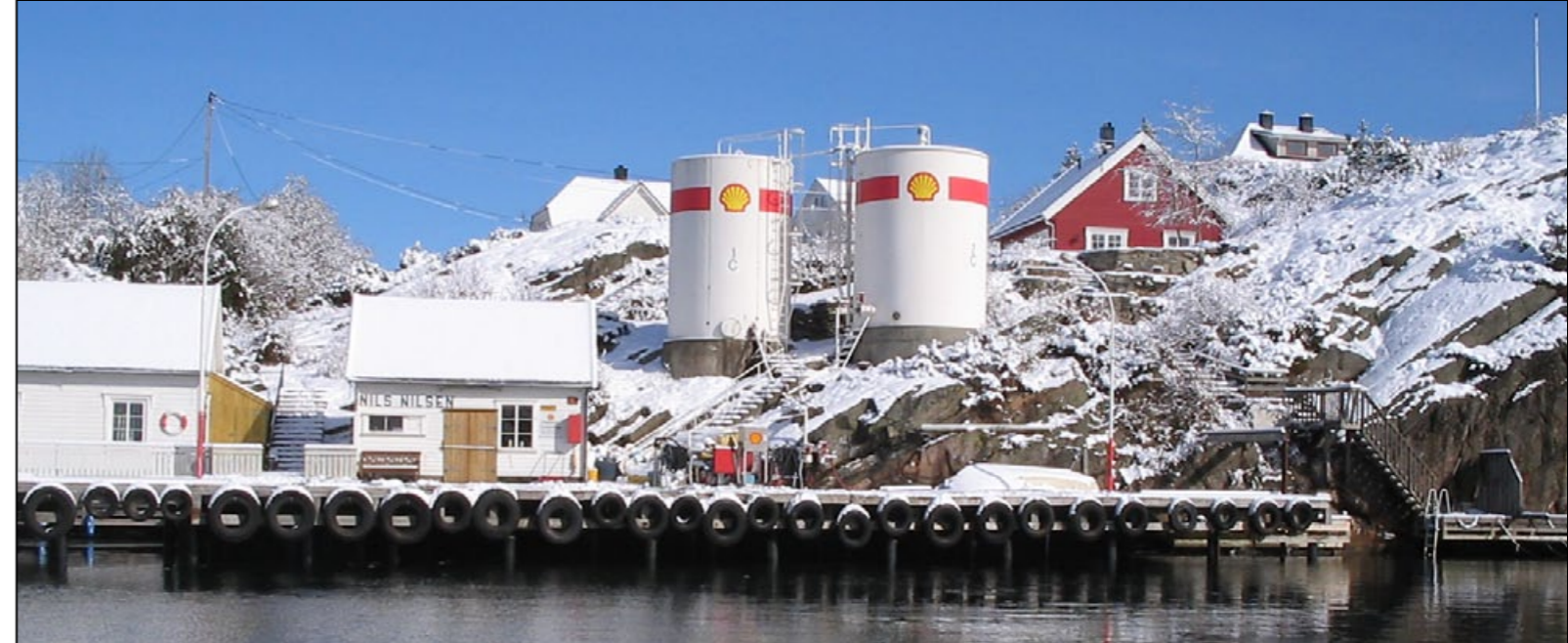
Tankanlegget ved Brattestø,Skibbusundet. Den ene tanken er revet.
