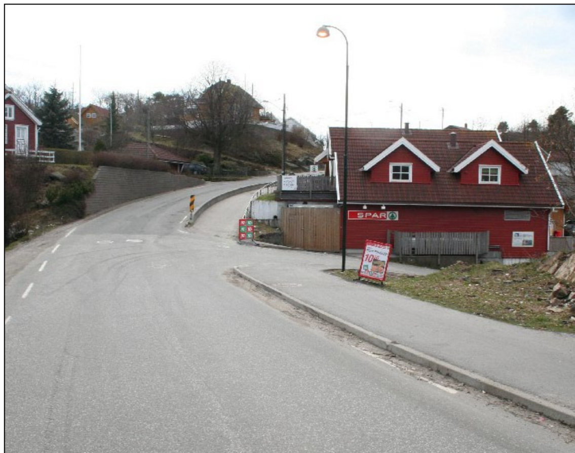
Fortau langs fylkesveien forbi Lindebø brygge. Avkjørselen til butikken har dårlig sikt.
